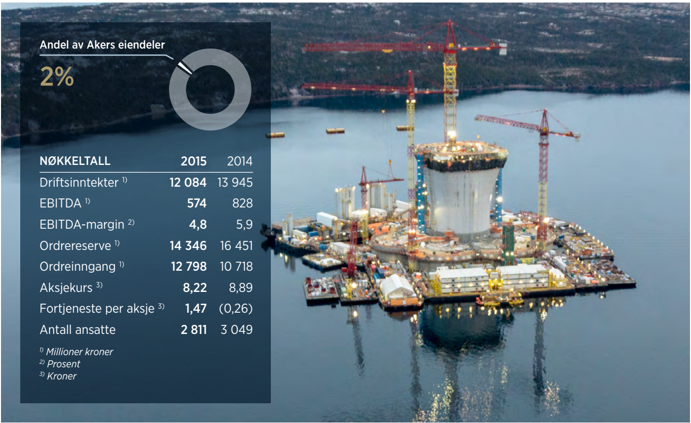
Betongunderstellet til plattformen på Hebron-feltet utenfor Newfoundland og Labrador.
