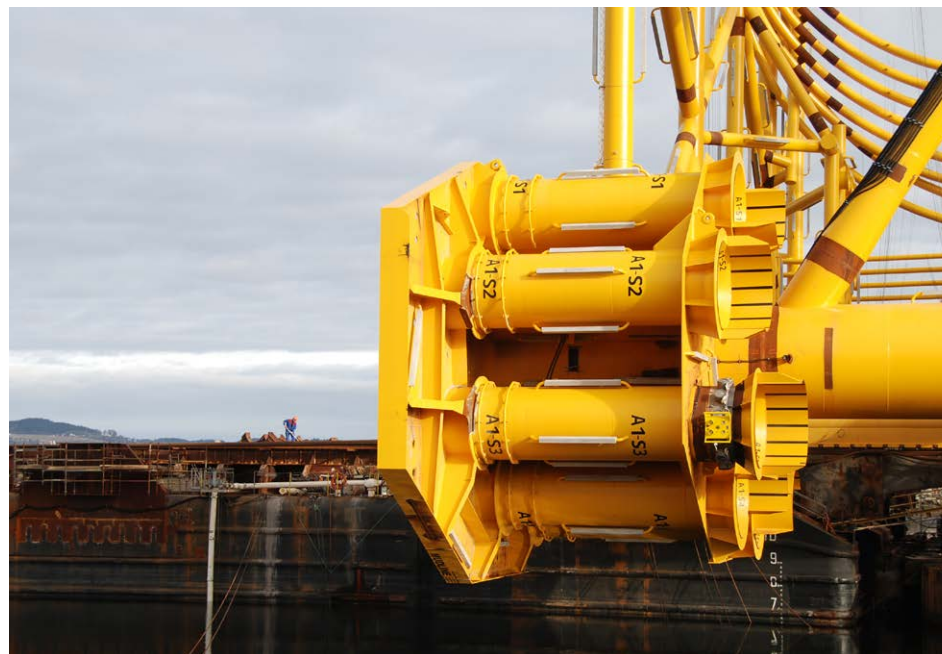
Kværner Verdal leverte stålunderstellet til Edvard Grieg-plattformen i 2014.
